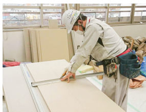
2 石膏ボードを寸法に合わせてカットting。
