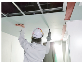
6 天井へのボードの貼り付け。
