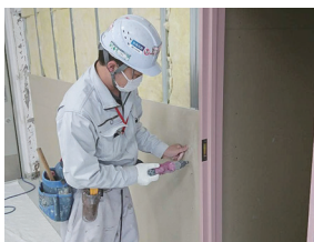
3 石膏ボードを壁に設置していきます。
