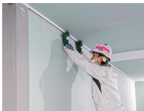
7 見切り縁を設置。
