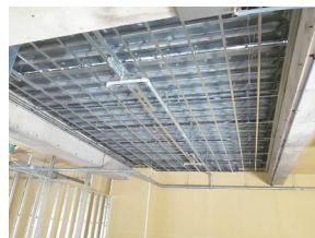
5 天井下地組み立て。
